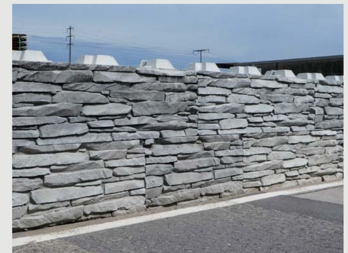
Mauerwerkstruktur in Schieferoptik – Brabant
